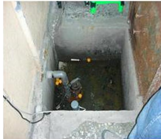
地下室集水槽
