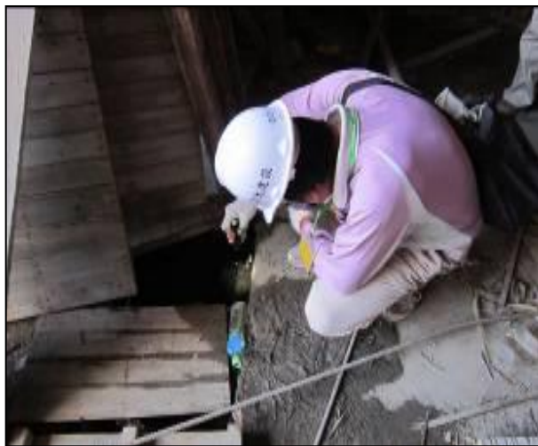
車道下方水溝
