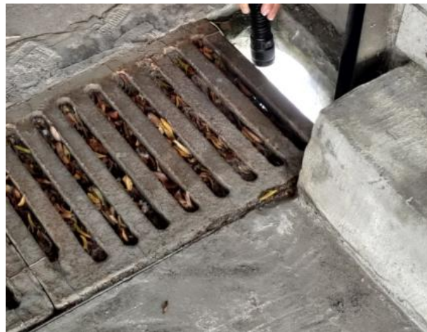
地下室車道下方水溝
