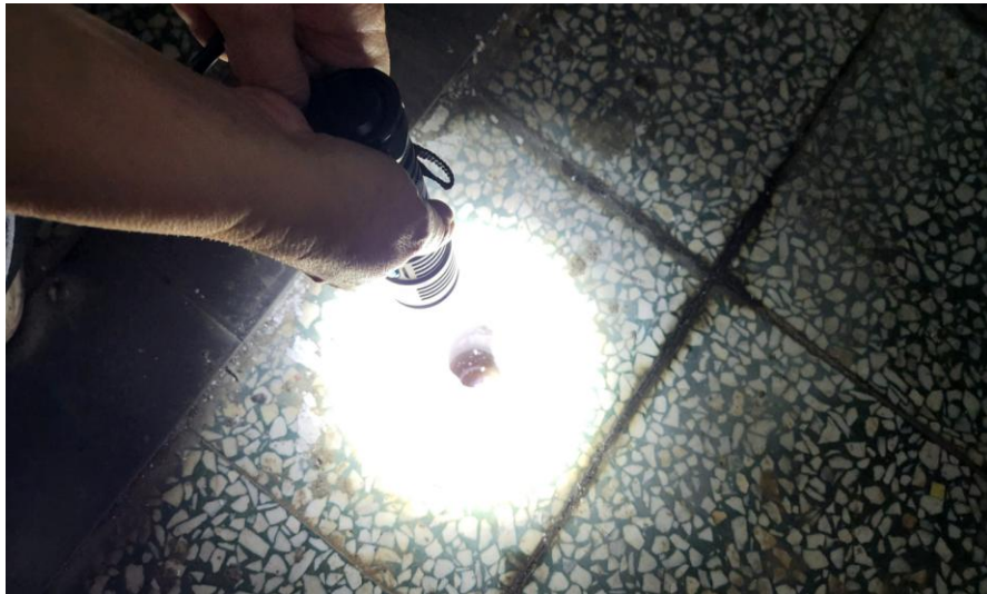
地下室排水孔
