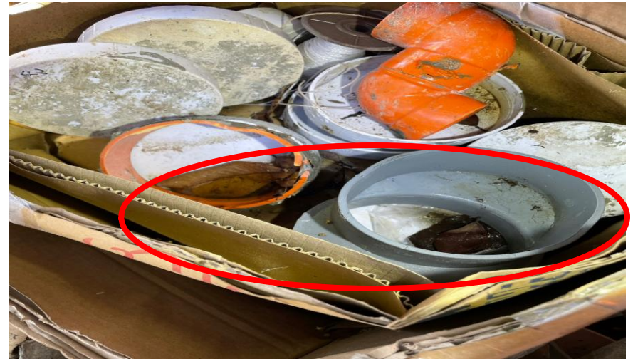
工地建材彎管、塑膠盤
