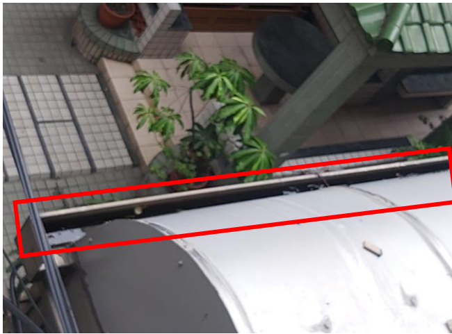
天溝(屋簷排水槽)
